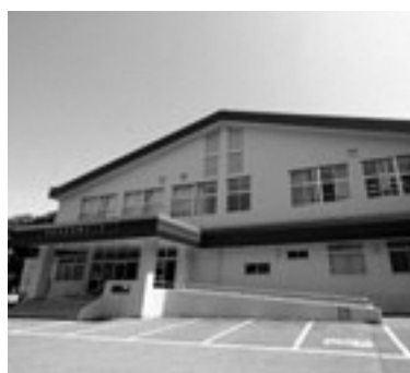
H29.3 市民体育センター耐震補強工事完了
