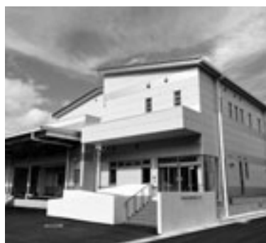
H28.9 学校給食センター完成
